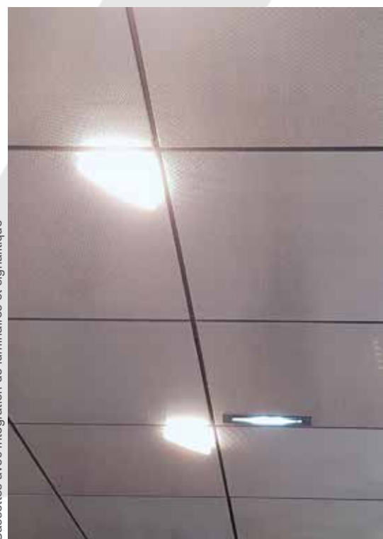
Cassettes avec intégration de luminaires et signalétique
