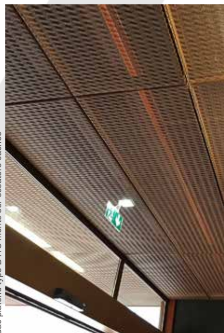
Bac plafond type D11S monté sur ossature cachée
