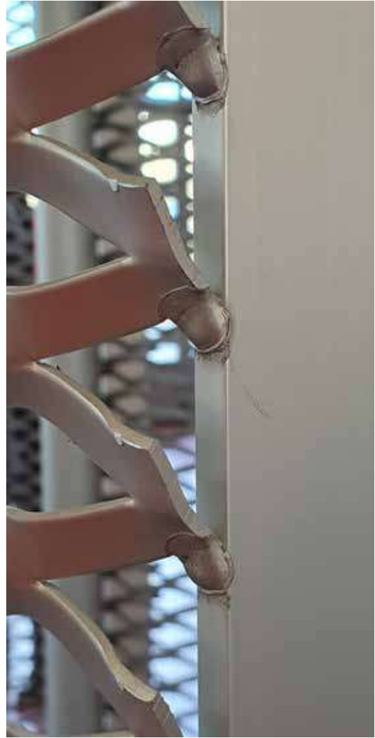
Métal déployé soudé maille par maille sur champ d'un cadre en profil plat
